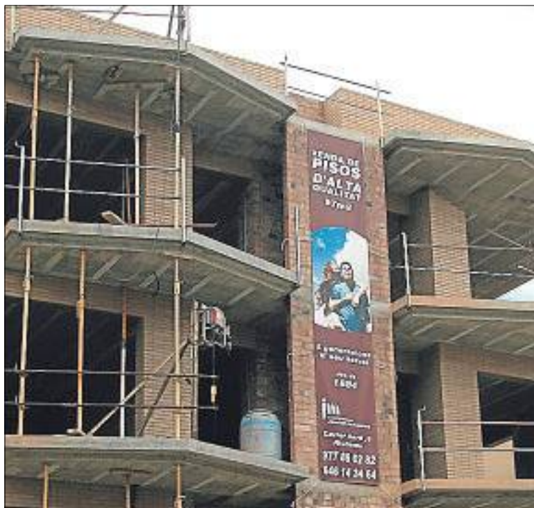
Bloc de pisos en construcció
